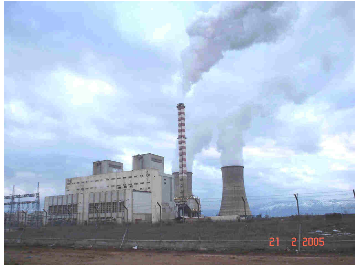
ΑΗΣ Αμυνταίου - Φιλώτα (Συμπαράγωγή Ηλεκτρισμού & Θερμότητας Η θερμική ισχύς τροφοδοτεί & την Τηλεθέρμανση ευρύτερης περιοχής Αμυνταίου).
